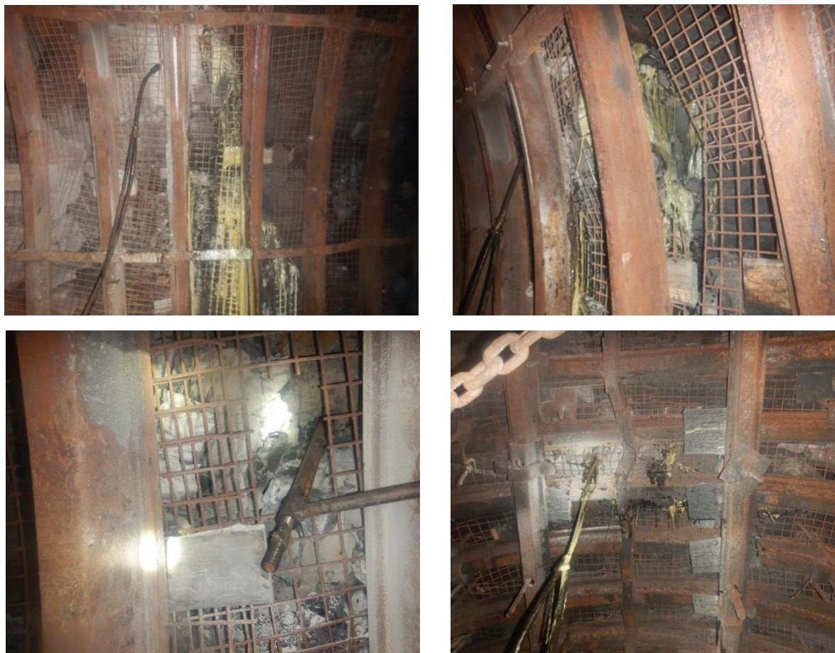
Рисунок 4.3 – Ілюстрація процесів нагнітання поліуретанової смоли в боки та покрівлю виїмкової виробки
