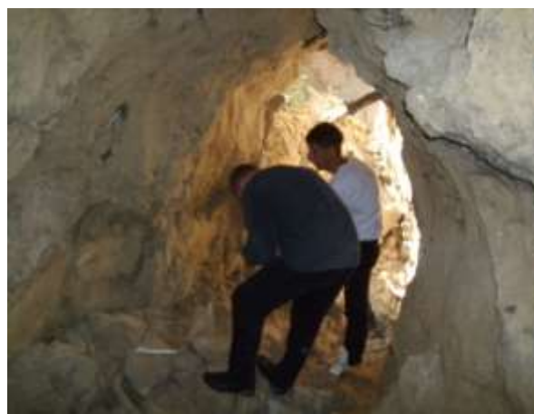
Рисунок 3.28– Проявлення суфозійних процесів у дамбі хвостосховища «Сухачівське» [147-149]
