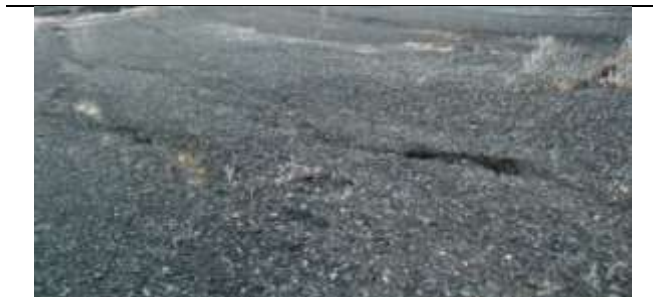
Рисунок 3.41 – Промоїни на схилах терас дамби хвостосховища ВГМК у балці «Скажена» [152]
