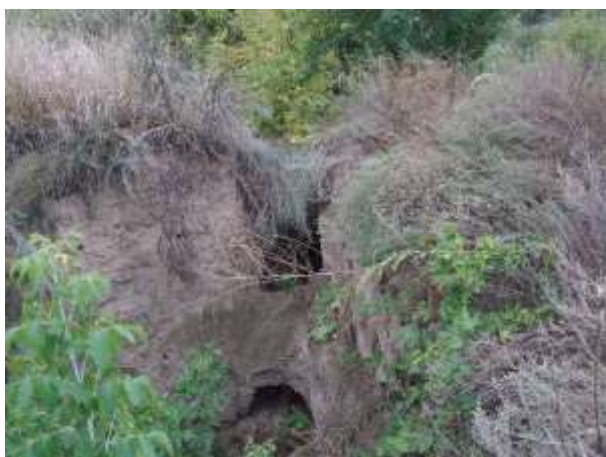
Рисунок 3.28– Проявлення суфозійних процесів у дамбі хвостосховища «Сухачівське» [147-149]
