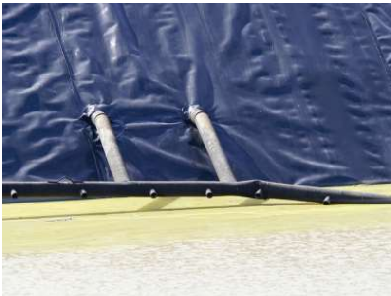
Рисунок 5.2 – Приклад застосування геосинтетичної ізоляції ґрунту на хвостосховищах [224]
