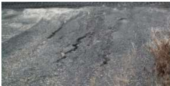
Рисунок 3.41 – Промоїни на схилах терас дамби хвостосховища ВГМК у балці «Скажена» [152]
