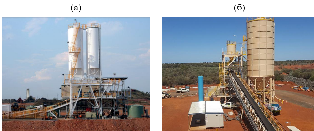
Рисунок 7.10 – Вигляд сучасних мобільних закладних комплексів модульного типу для приготування пастової закладної суміші: (а) золотий рудник Карарі; (б) золоторудна шахта Сарацен [312]
