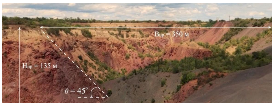
Рисунок 3.20 – Геометричні параметри провальної зони шахти «Козацька» ПАТ «Кривбасзалізрудком»
