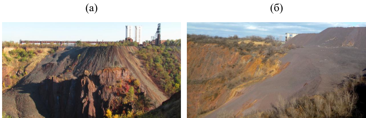
Рисунок 1.15 – Засипання провальних зон шахтними породами:
